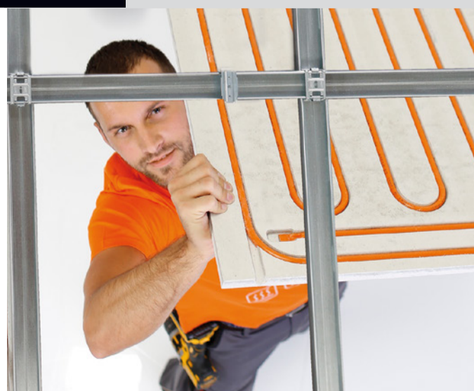
Rückseite einer Akustikplatte: mit integriertem VarioModul-Rohr und Akustikvlies
