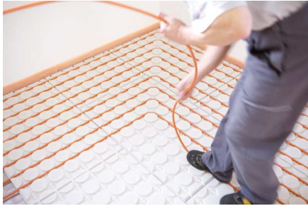
Trockenbau Fußbodenheizung, VarioKomp
