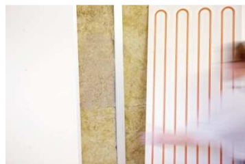
Montage der Variotherm ModulWand (mit den Rohren auf der Rückseite)
