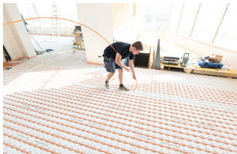
336 m 2 VarioKomp-Platten wurden als Trockenbau-Fußbodenheizung verbaut.
